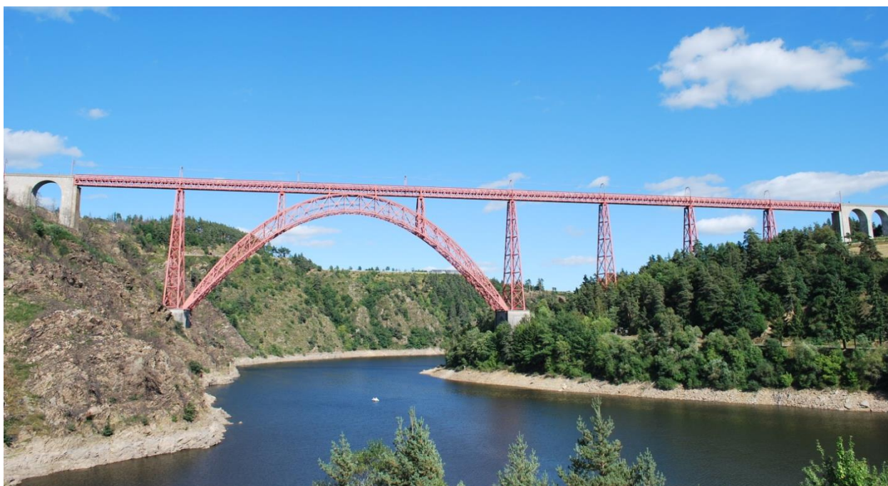
Ligne des Causses Béziers-Neussargue. Le viaduc métallique de Garabit enjambant la Truyère. Un coût d'entretien très élevé qui n'est pas compensé par la faiblesse du trafic ferroviaire. Photo. JMT 2016.
