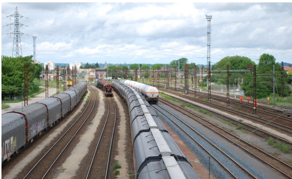
Gare de triage d'Ambérieu en Bugey (Ain). 45 voies dédiées et un nœud ferroviaire entre Lyon, Chambéry et Bourg en Bresse-Paris. Photo. JMT 2020.
